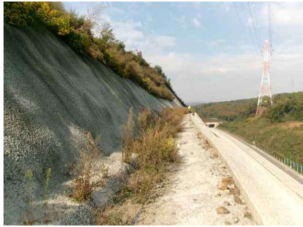
1소단 배수로 전경
